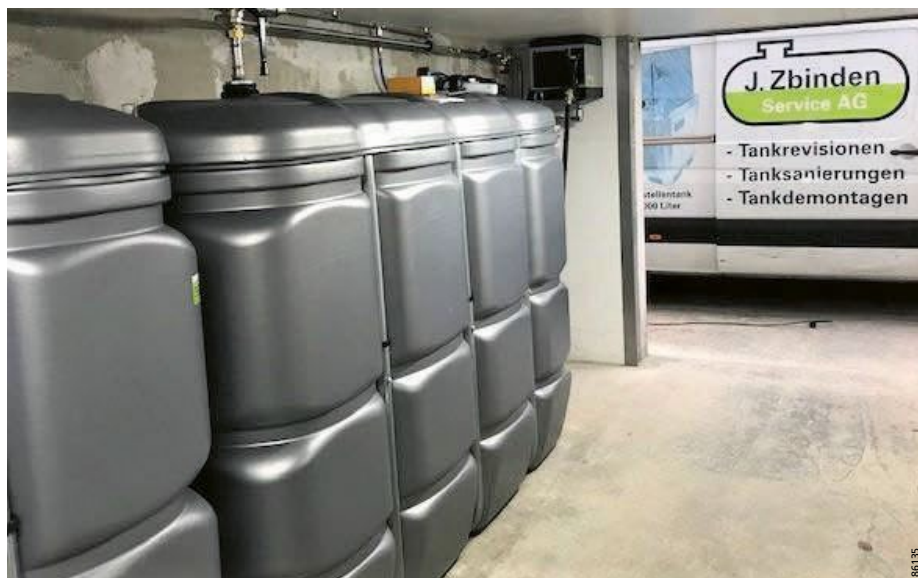
(Bild: Neue Dieselöl-Kleintankanlage 2 x 2000 Liter mit Kompaktsäule)
