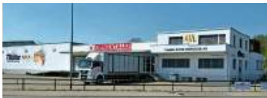
Das Käsereifungslager ist auf die Lagerung von Emmentaler-Käse ausgerichtet.
