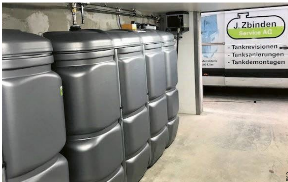
(Bild: Neue Dieselöl-Kleintankanlage 2 x 2000 Liter mit Kompaktsäule)
